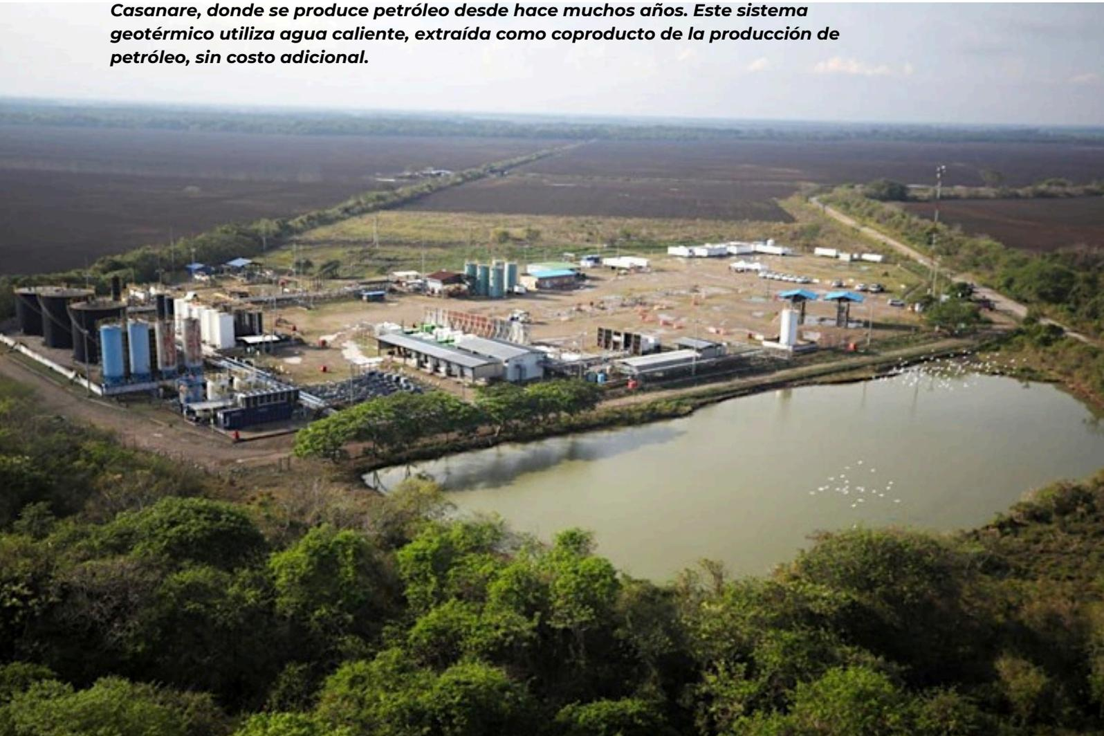
**Figura 2. Primera planta de energía geotérmica inaugurada en el campo Las Maracas, Casanare, Colombia**
