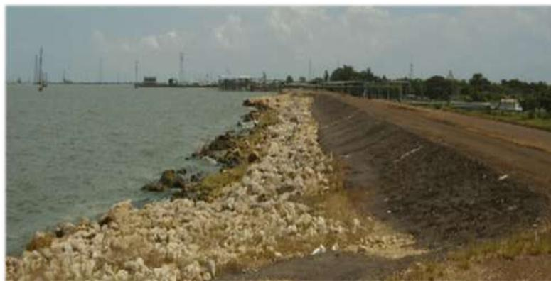
El agua no ha inundado los campos debido a la protección del dique de contención conocido como el Muro, conjuntamente, con un sistema asociado de canales que sirven para recolectar las aguas de lluvias y otras corrientes.
